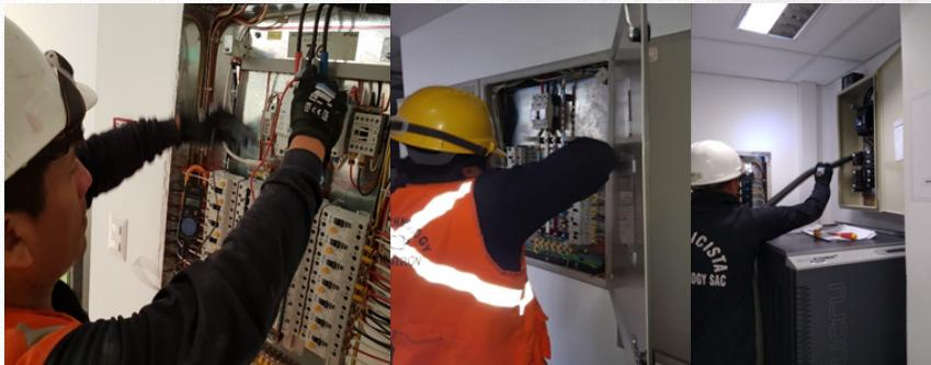
El mantenimiento preventivo, es un procedimiento periódico que tiene como finalidad minimizar el riesgo de falla y asegurar la continuidad de los equipos e instalaciones del sistema eléctrico existente.
